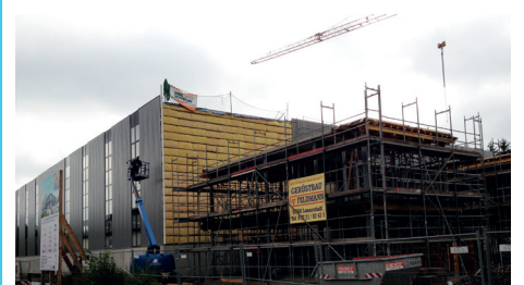
Baustelle im September 2012
